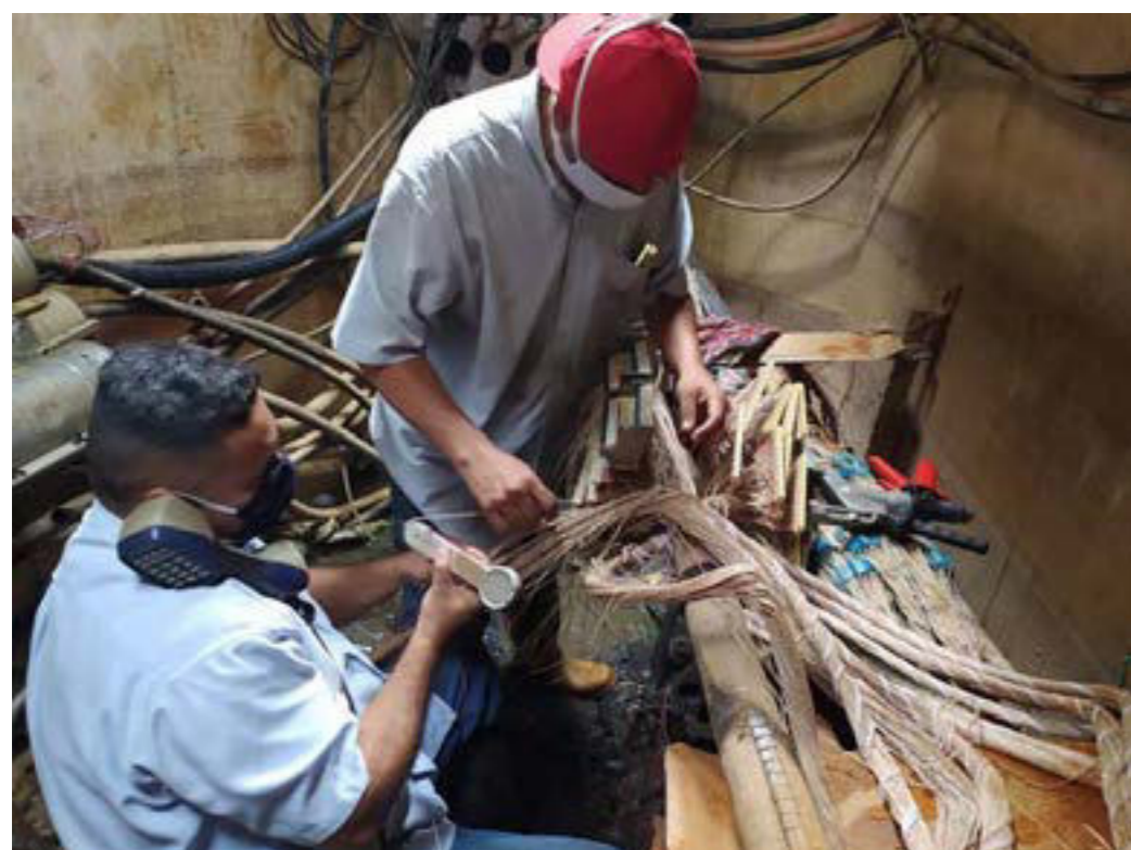
Figura 2. Cantv está restaurando los servicios de telecomunicaciones durante la pandemia, a 55.471 suscriptores de Caracas, Miranda y La Guaira -entre hogares y comercios- que se encontraban afectados por deterioro de las redes, robo de cables y daño malicioso contra el material estratégico de la Empresa, les llegó el servicio..
